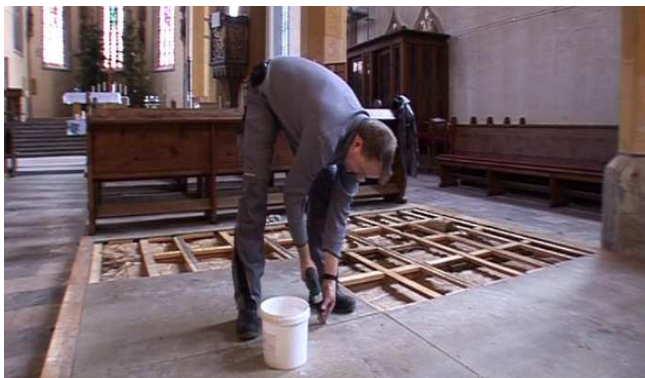
Bauarbeiten in der Stadtkirche St Michael
